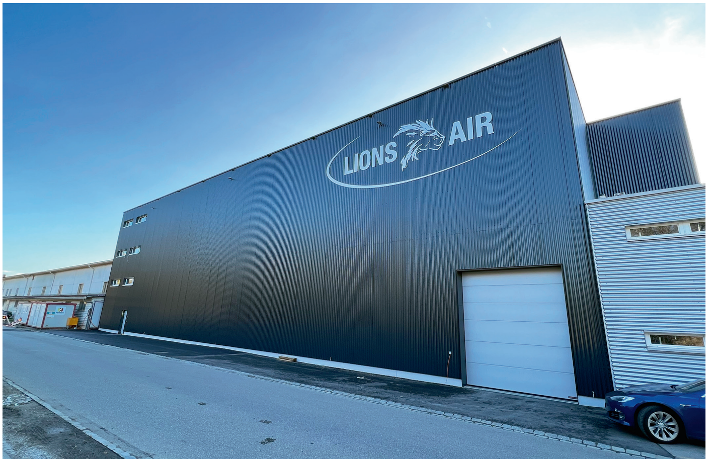
Der neue Hangar der Lions Air Group am Flughafen Bern.
