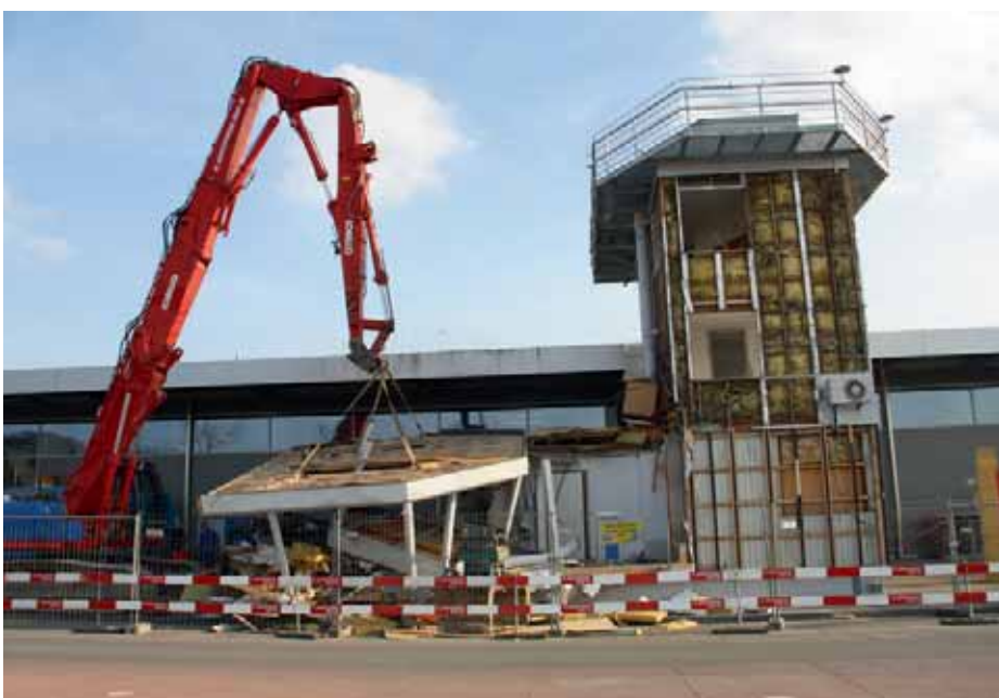
Oben: Abtransport der Metalltreppe für einen neuen Verwendungszweck.
