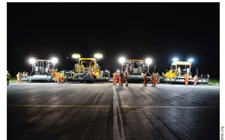
Belagseinbau mit vier verbreiterten Asphaltfertigern.
