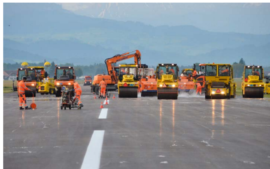
Kurz vor 6 Uhr nach dem Einbau der ersten Deckbelagsetappe.
