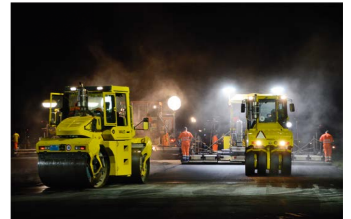
Nächtliche Bauarbeiten sind besonders anspruchsvoll.
