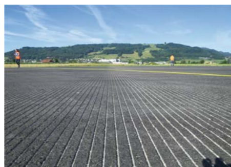
Fertig sanierter Belag mit Grooving (Pistenrillierung).
