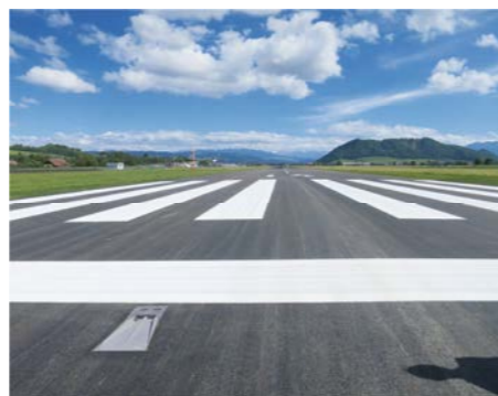
Fertig sanierte Piste mit Markierung der Landeschwelle 14.
